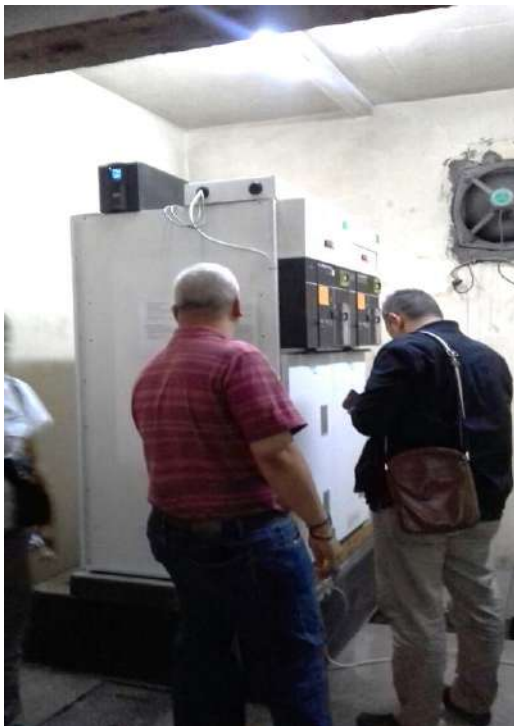
Pemasangan Cubicle di Bandara Internasional Ahmad Yani Semarang
