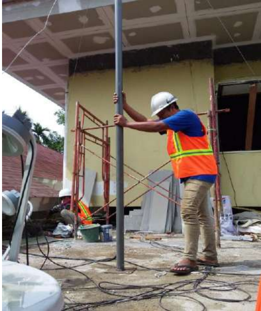
Pekerjaan Instalasi Penangkal Petir di Setneg Jakarta
